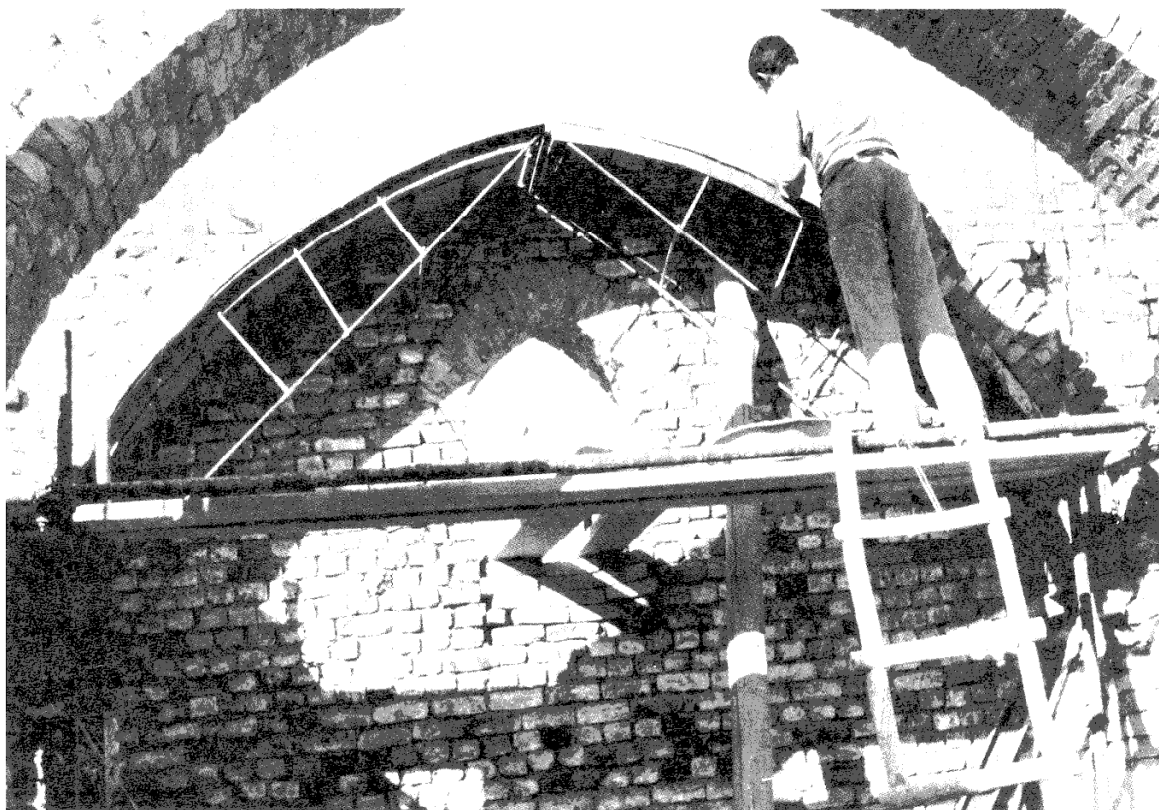
تصویر ۱ اشتهاورد - امامزاده، اجرای قوس رومی با استفاده از قالب دید.
