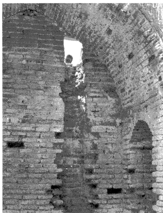
تصویر ۱ ارومیه - مسجد جامع، آهن‌کشی، جاسازی در دیوار بر پایه عمودی.
