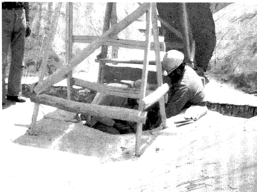
تصویر ۳ ارومیه - مسجد جامع، آهن‌کشی، پایه‌های کبکی عمودی در روی بام بر روی پایه‌های اصلی بنا.
