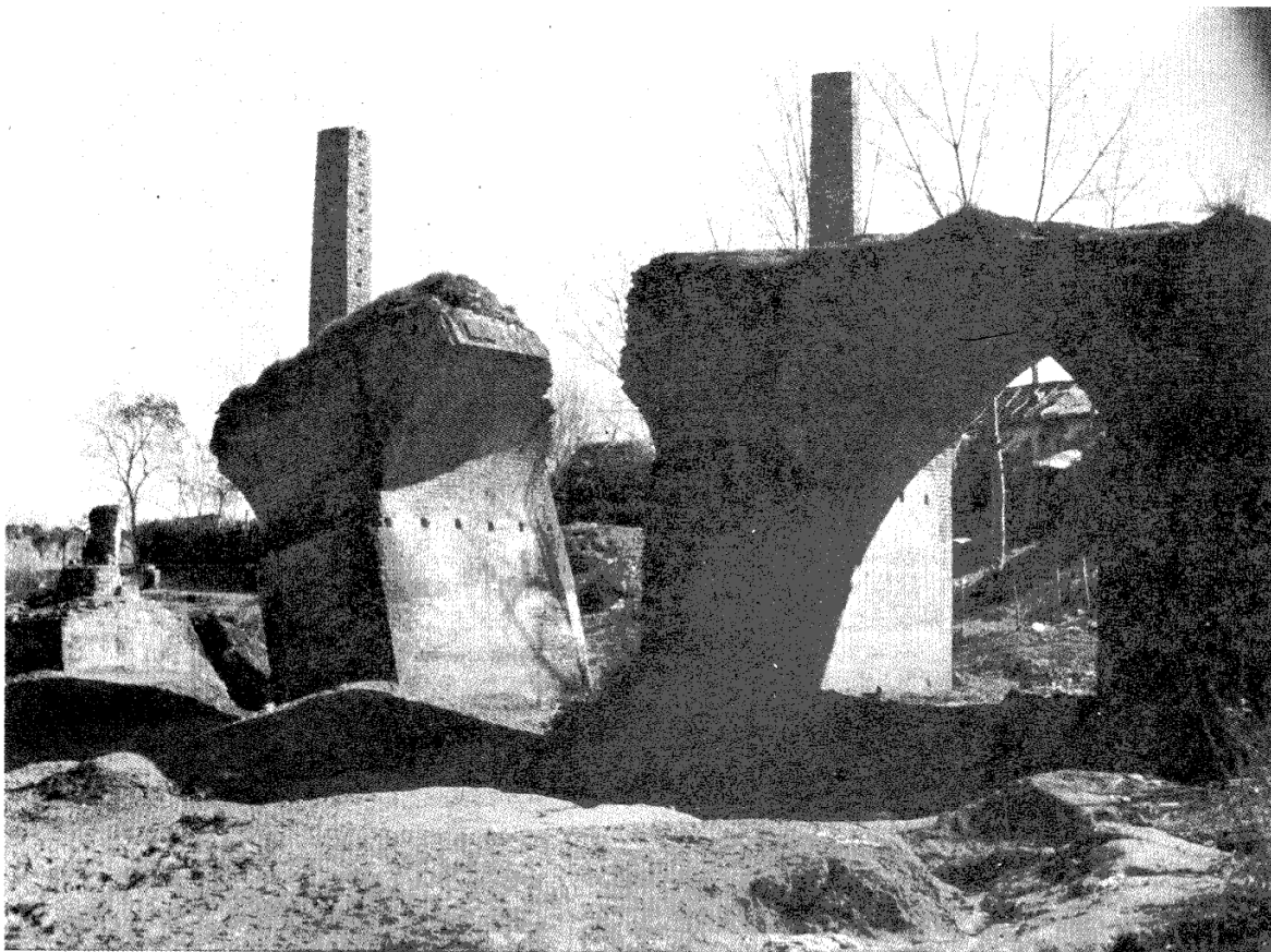
تصویر ۱ ساری، فرح آباد - پل رودخانه تجن، آسیب بر اثر سیل.
