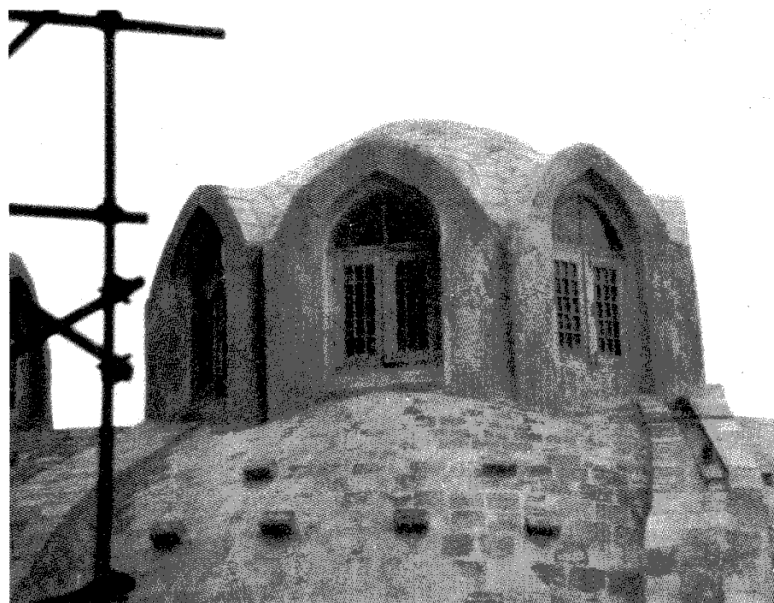
تصویر ۱۵ ماهان - مقبره شاه نعمت‌الله ولی، یکی از نورگیرهای پوشش سقف. نحوه اتصال میل مهارها به کمک کلاف آهنی و پیچ و مهره.
